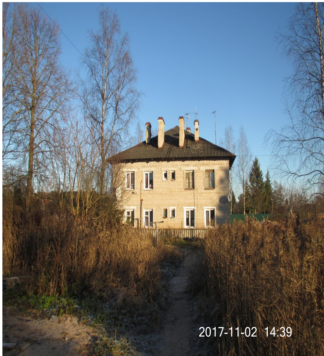
вид на дом со стороны дома культуры
