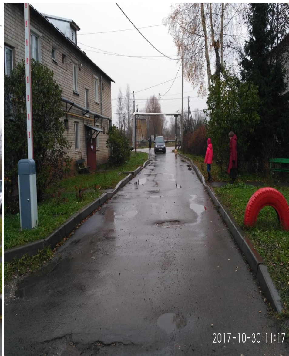
вид со двора на ул. Центральная
